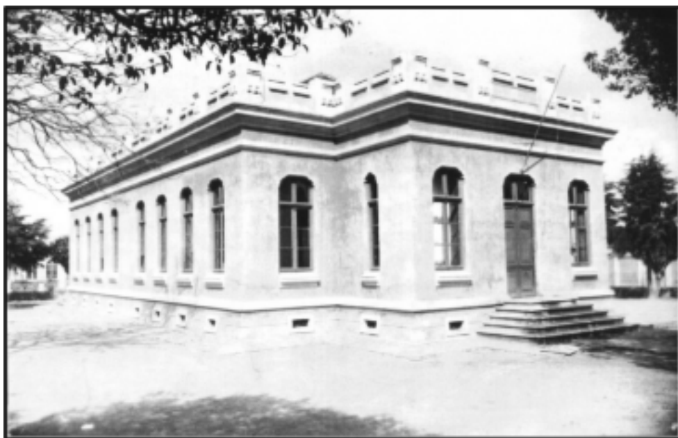
Foto 9 - Prédio do Grupo Escolar "Senador Correia" (1912) na Praça Roosevelt, s/nº.
