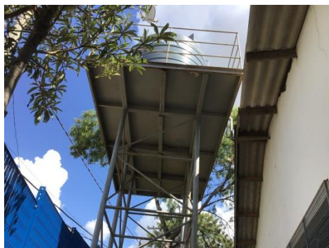
Figura 11 – Caixa D'água na Escola
