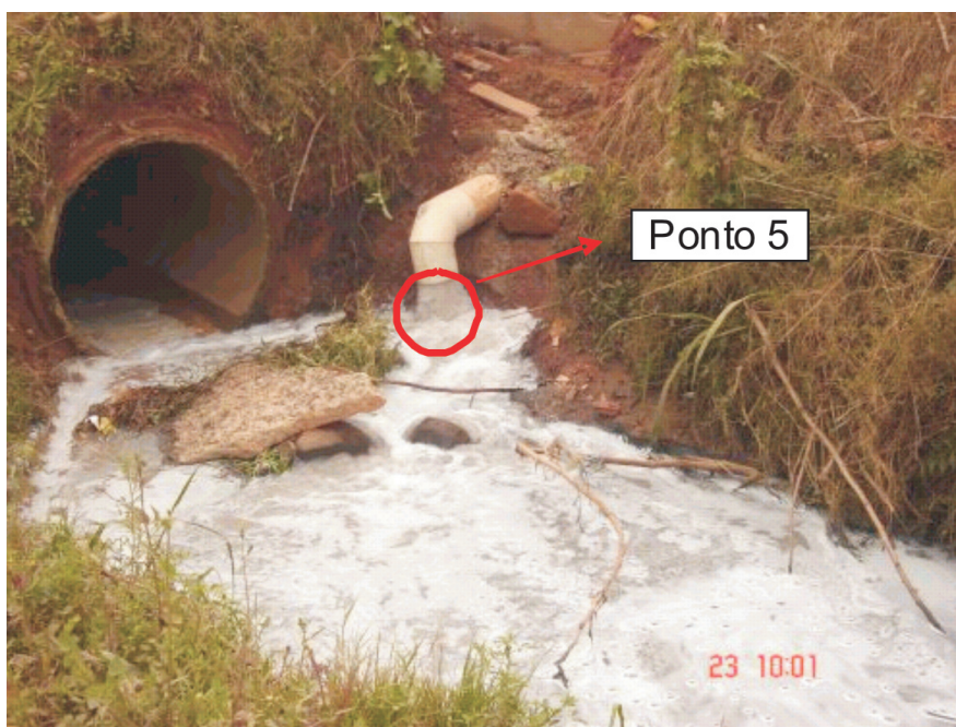
FIGURA 2 - Ponto de lançamento do efluente industrial no Córrego Sem Nome (nº 5)
