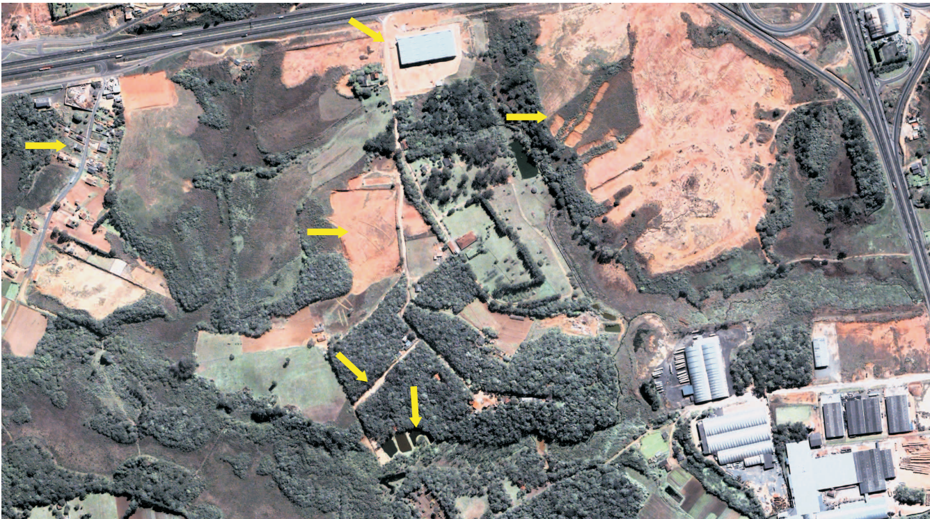
FIGURA 11: Situação da bacia nas proximidades do entroncamento da BR-376 com o Contorno Leste – 2004. Figure 11: Basin situation in the neighborhoods of the crossing between BR-376 with East Contour road - 2004.
