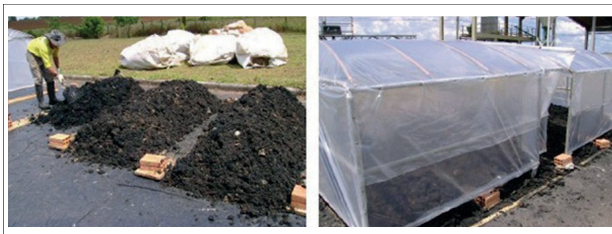
Figura 1 - Formação das leiras de lodo e estrutura de cobertura
