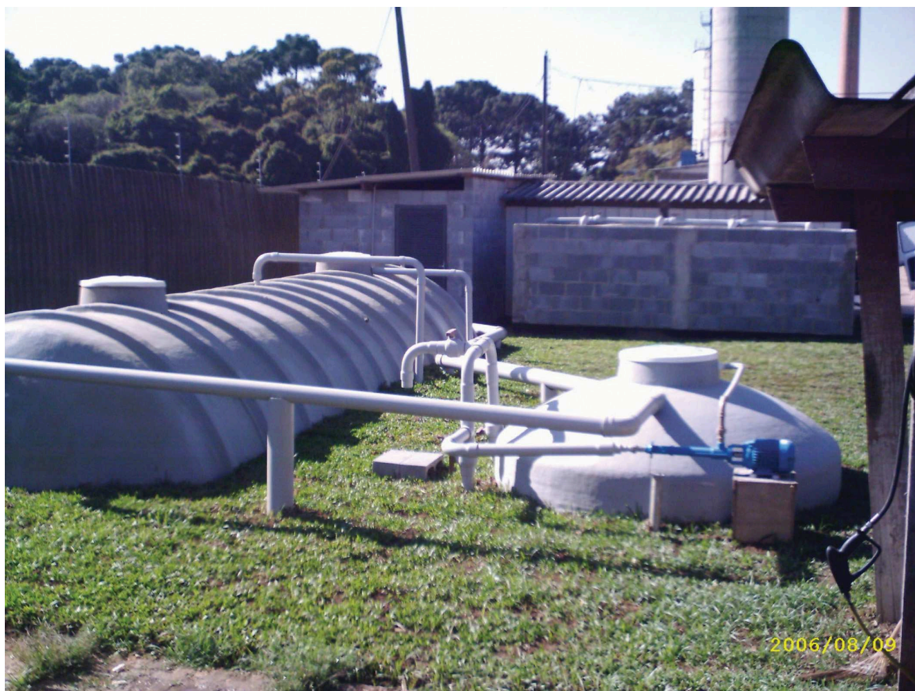
FIGURA 10 - Vista geral da Estação de Tratamento de Esgoto (ETE)
