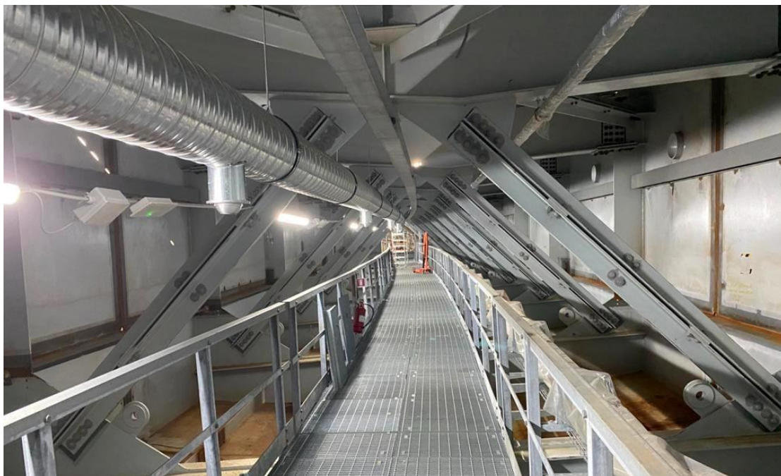
Figura 15 – Interior do tabuleiro com as instalações tecnológicas. Fonte: Shunji Ishida (2020).
