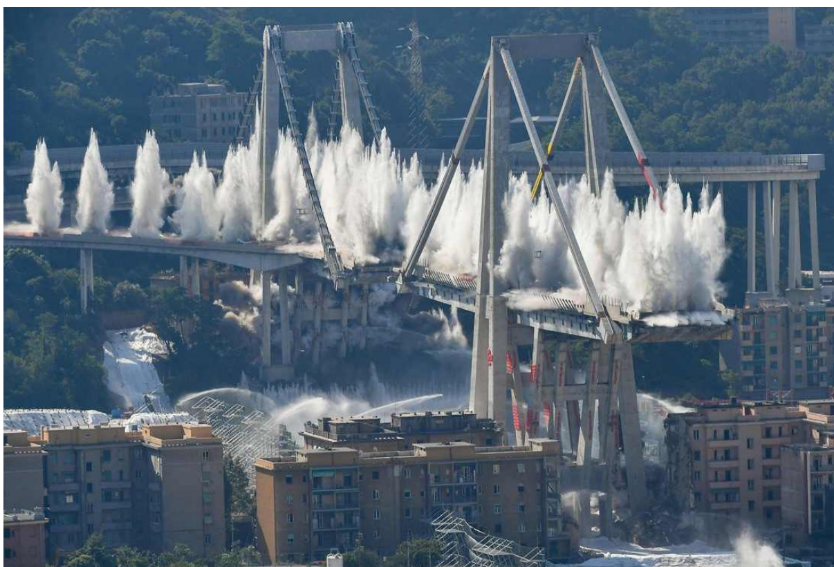
Figura 9 – Demolição da antiga ponte Morandi em Génova, Itália. Fonte: Adaptada de ITALFERR (2019).
