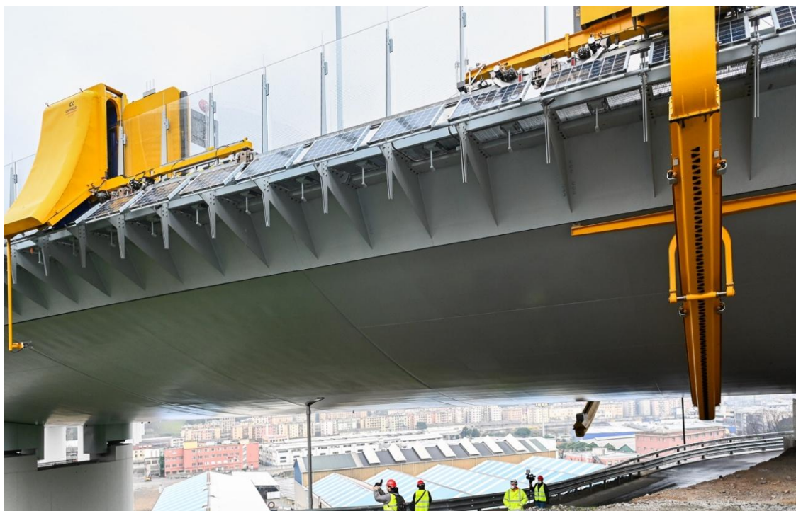
Figura 14 – Painéis fotovoltaicos instalados nas laterais da Ponte San Giorgio e braços robotizados para limpeza – PÓS-RETROFIT. Fonte: Shunji Ishida (2020).
