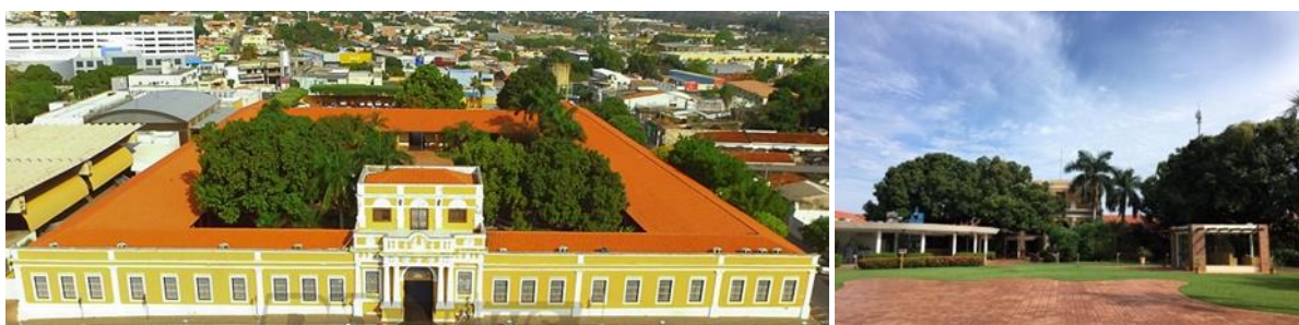
Figura 4 – Edifício Arsenal de Guerra (à esquerda) e do seu pátio interno (à direita). Fonte Adaptado de RD News (2021). Foto da esquerda de Rodinei Crescêncio.
