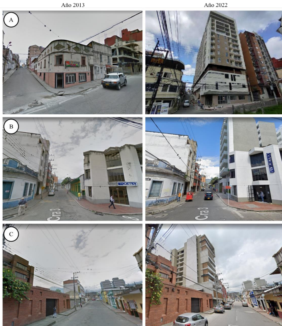
A) Edificio Entreparkes. 15 pisos de altura. B) Flormorago. 11 pisos de altura. C) Edificio Tempo. 11 pisos de altura.
