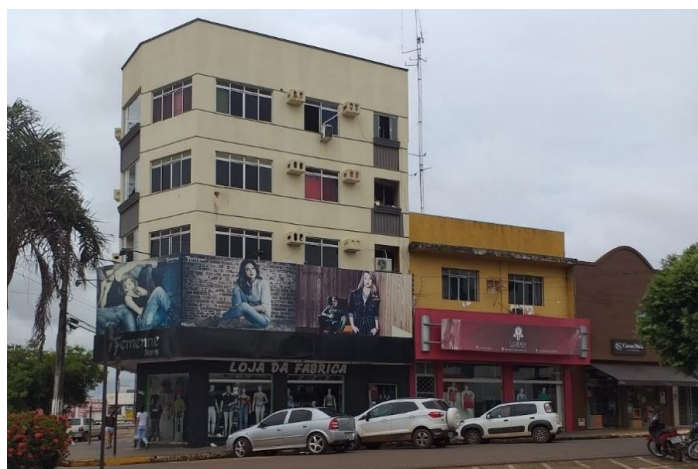
Figura 7 – Conjunto Urbano de Domicílios do Setor 2, Cacoal, 2020. Fonte. Arquivo próprio.
