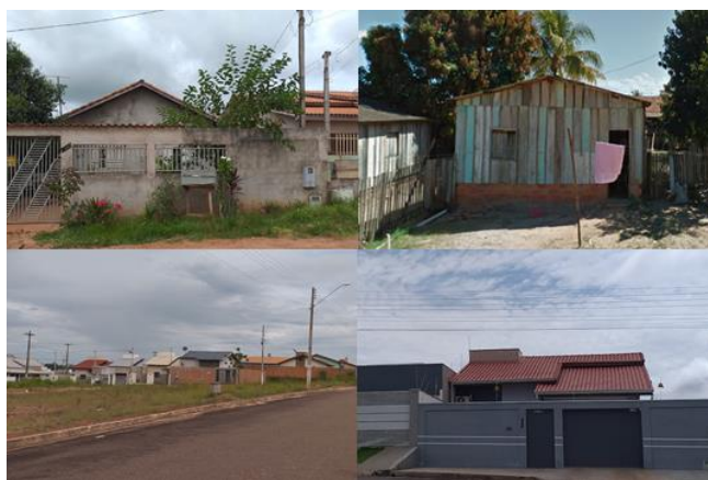
Figura 6 – Conjunto Urbano de Domicílios do Setor 1, Cacoal, 2020. Fonte. Arquivo próprio.
