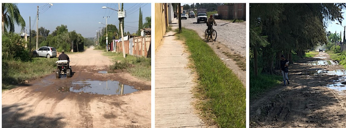
Figura 10 - Características de las vías de acceso en el fraccionamiento Jardines de La Calera.
