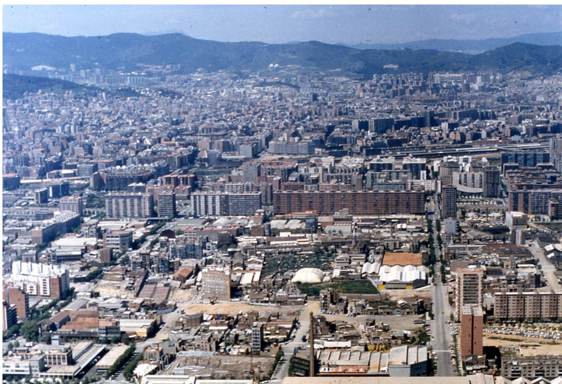
Figura 11 - Vista aérea do final da avenida Diagonal no ano de 1986. Fonte: CCRS Arquitetos (1986).
