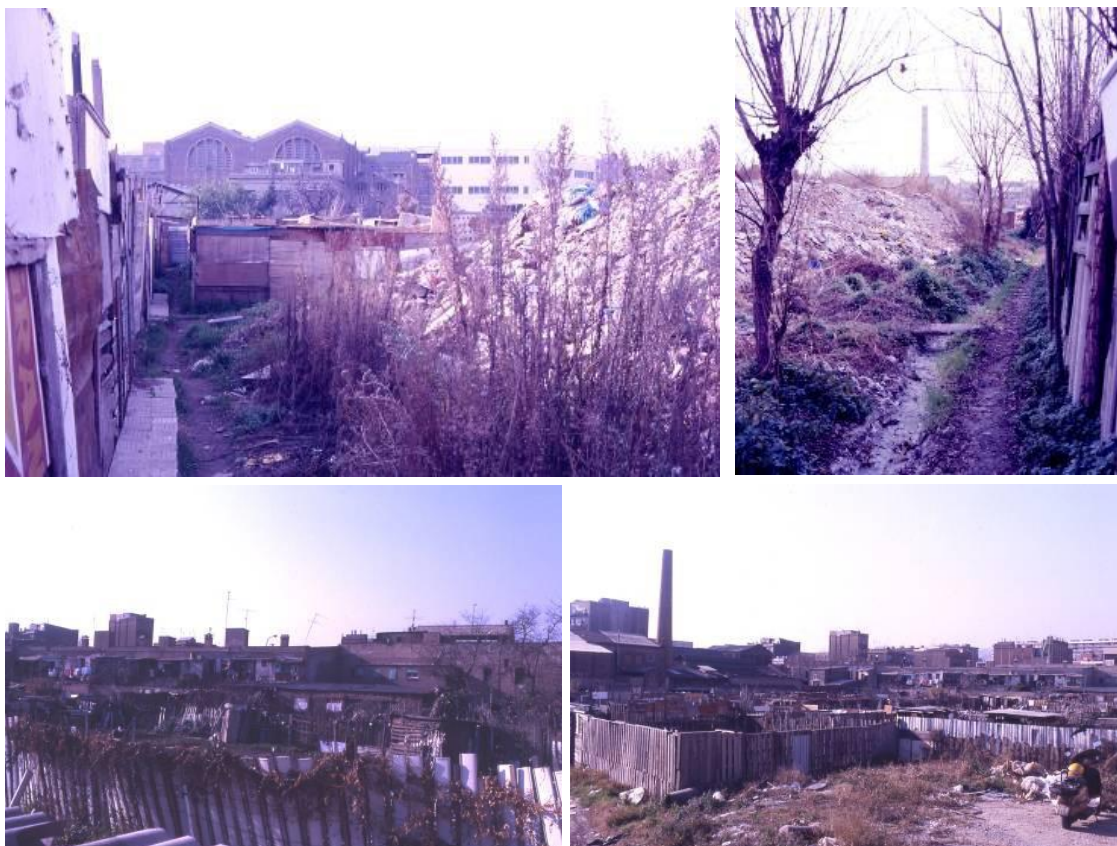
Figura 17 - Estado das construções, 1986. Fonte: CCRS Arquitetos (1986).
