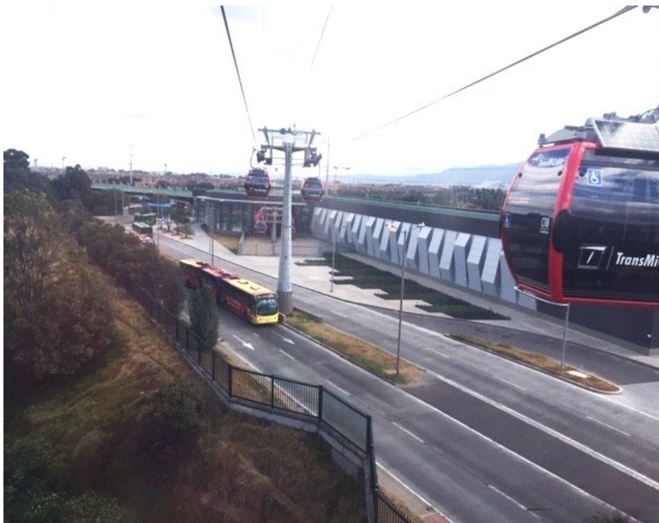
Figura 3 - Vista desde Transmicable hacia estación de intercambio modal "Portal Tunal". Fuente: Elaboración propia - Foto tomada por el autor.
