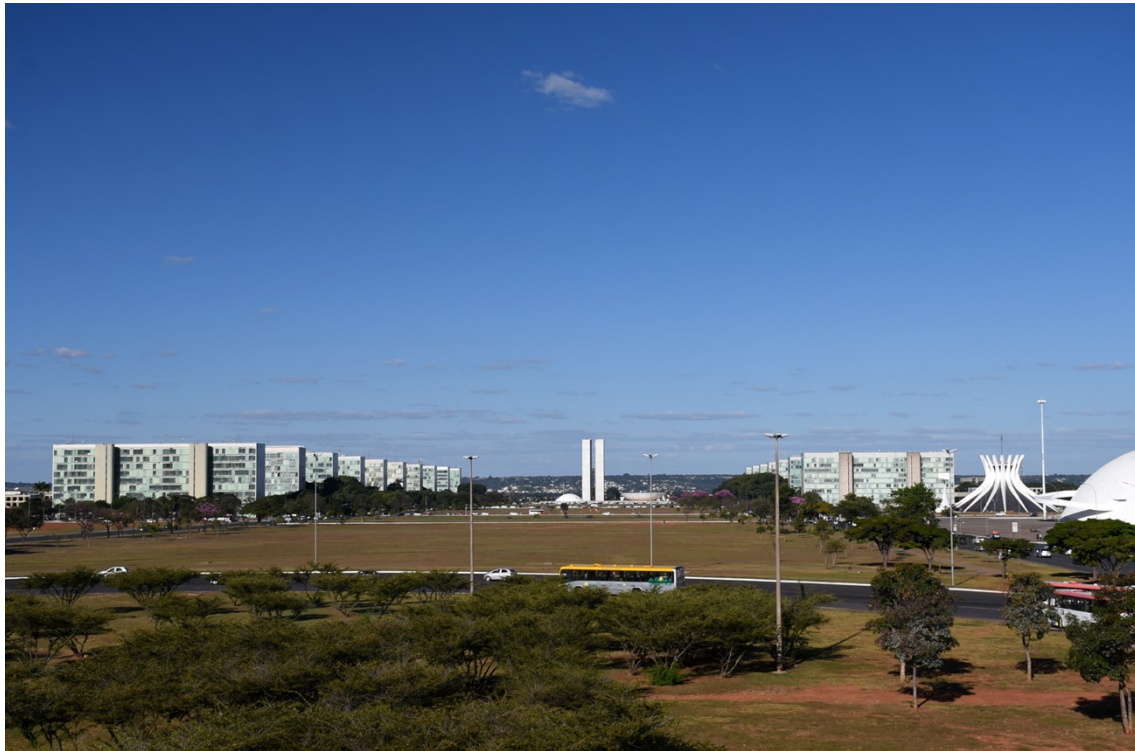
Figura 10 - Esplanada dos Ministérios, vista do deck superior da Plataforma Rodoviária.
