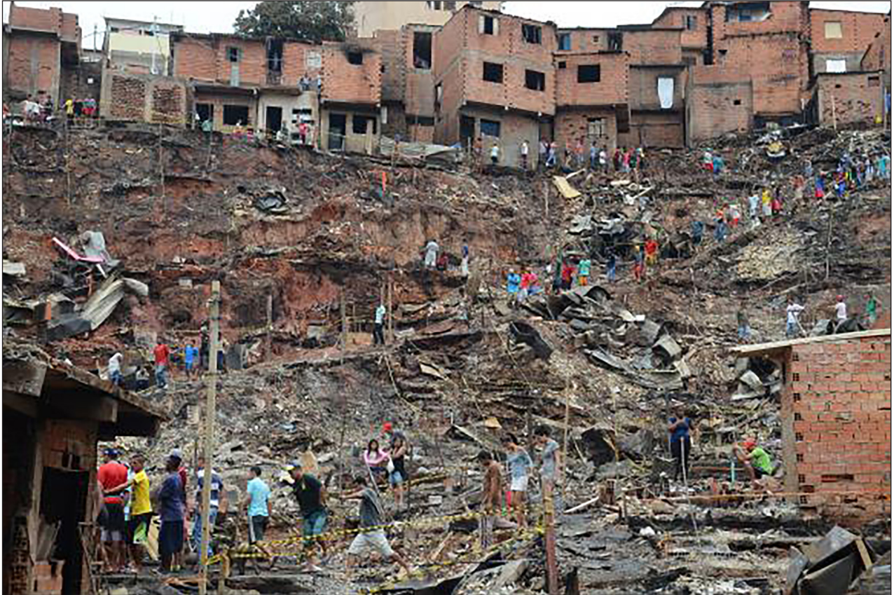
Figura 12 - Incêndio na área da Escola de Música, em março de 2017
