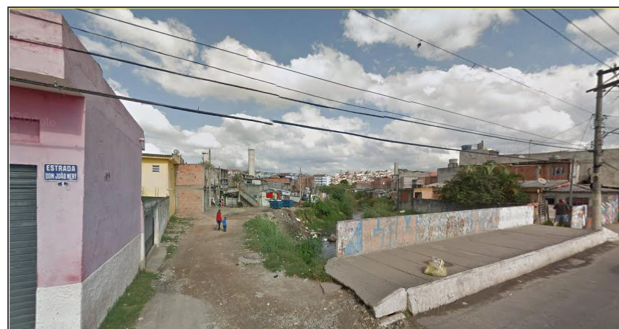
Figura 11 - Marginal do Córrego do Lajeado no cruzamento com a Estrada Dom João Nery. Observa-se o desmoronamento da margem Fonte: Google Street View (2017).
