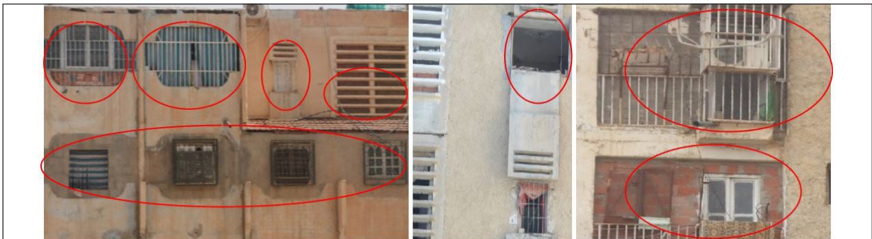
Figure 2 - Les transformations des façades. De gauche à droite: cité 442 logt-Hassi-Messaoud, cité 1000 logt-Biskra, cité 400 logt-Ouargla
