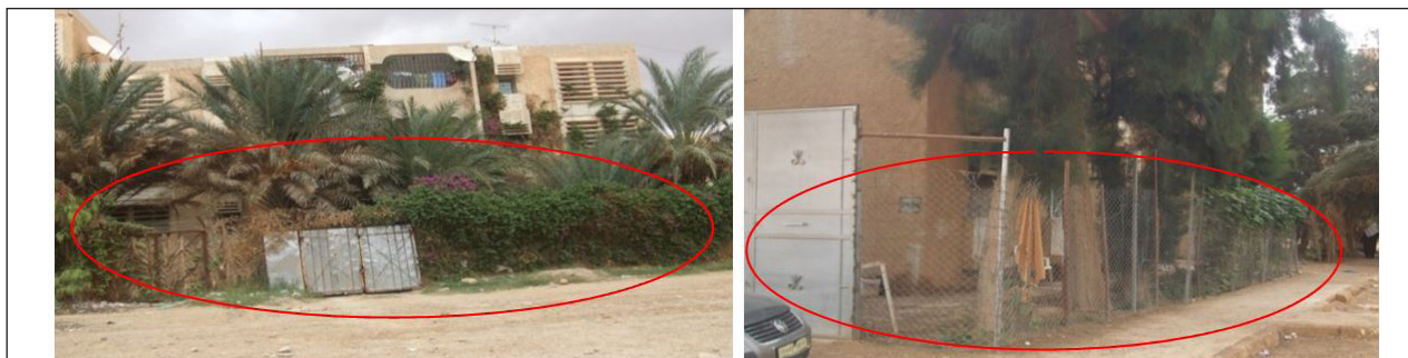
Figure 4 - Le "clôturage" barbelé par des végétations. De gauche à droite: Cité 1000 logt-Biskra, cité 400 logt-Ouargla
