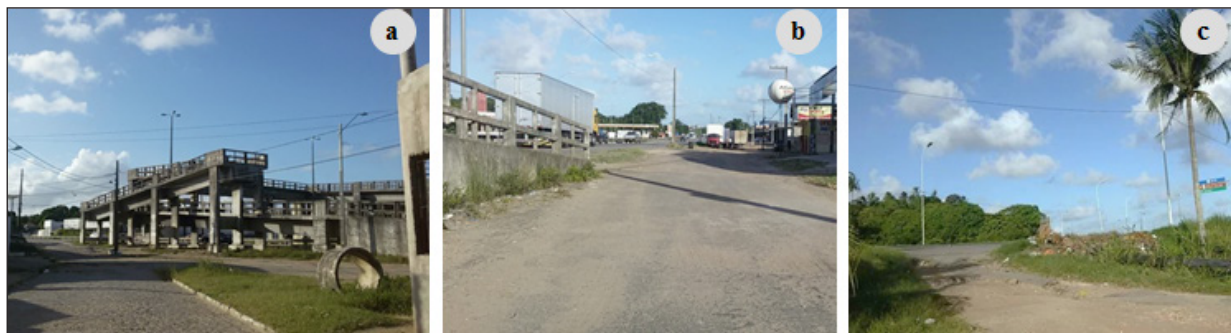
Figura 15 - (a, b) Passarela para pedestres sobre as rodovias; (c) Um dos acessos a Três Lagoas partindo da rodovia Fonte: Yasmin Peregrino (2016).
