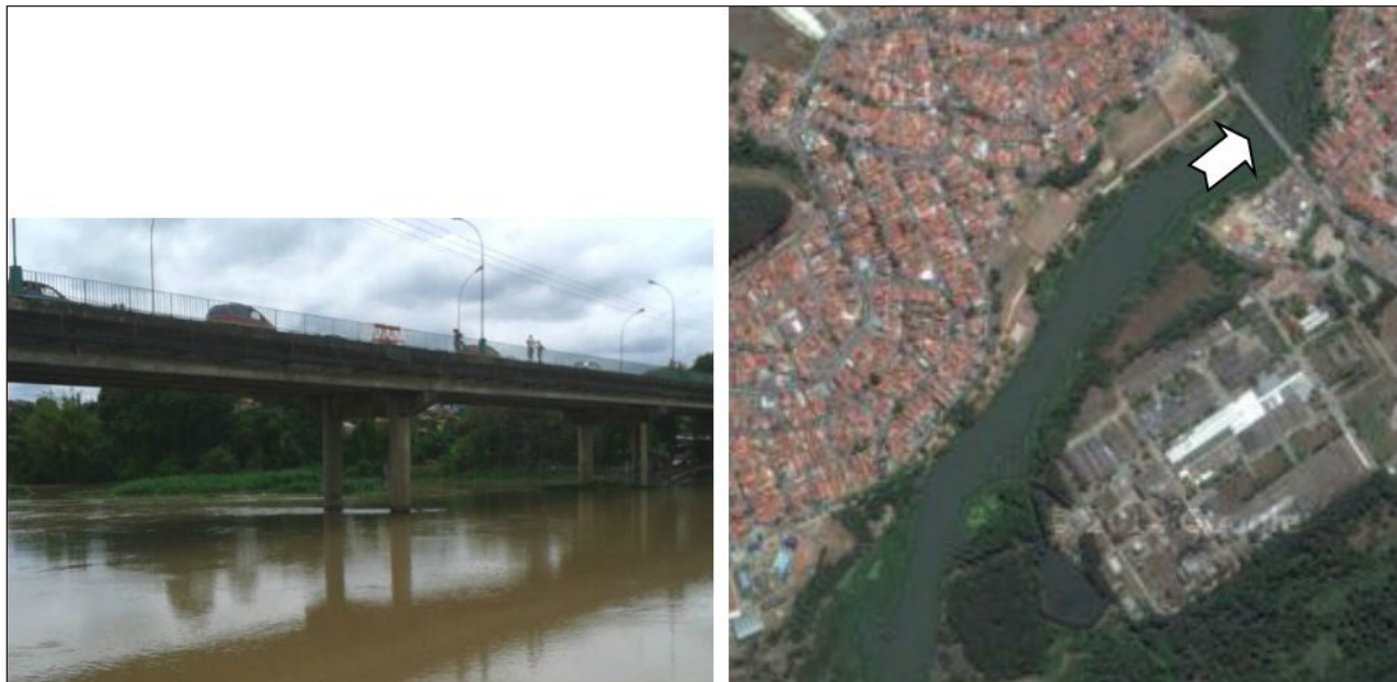
Figura 7 - (a) Ponte Maria Peregrina, em Santana, (b) e sua localização sobre o rio Paraíba Fonte: Google Earth (2016).
