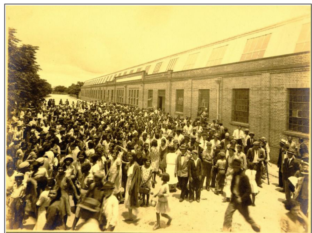
Figura 8 - Vista da Tecelagem Parahyba, em Santana (1957)
