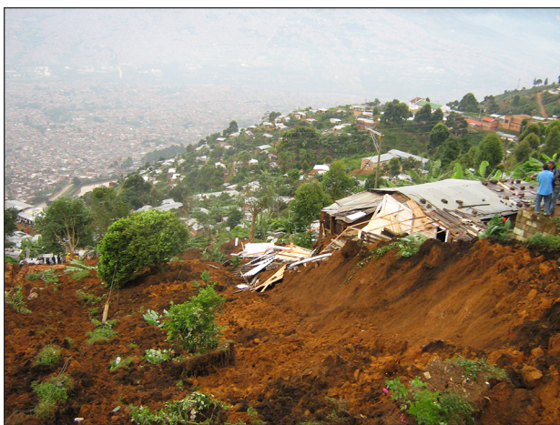
Figure 7 - Aftermath of landslide in Barrio La Cruz, 2007 Source: Departamento Administrativo de Planeación Medellín (2007).
