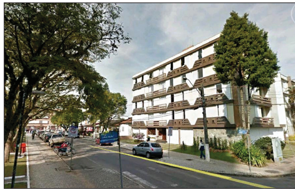
Figura 3 - Edifício Dr. Jorge, de 1972.
