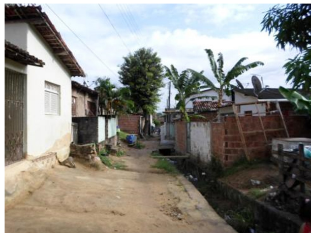
Figura 7 - Córrego do Balaio: canaleta de drenagem aberta Fonte: UFPE; SPU, 2013b.
