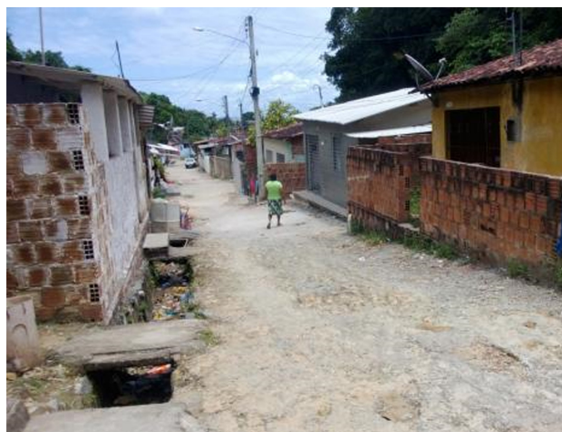
Figura 6 - Córrego do Balaio: muros avançando na via principal Fonte: UFPE; SPU, 2013b.
