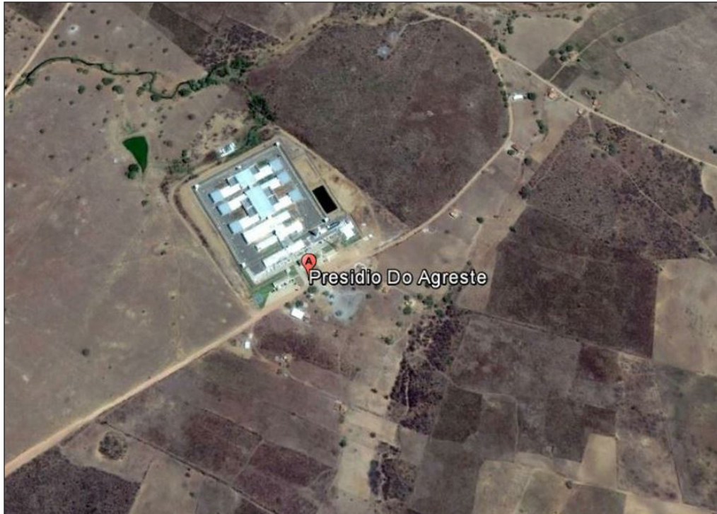
Figura 10 - Instalações da nova unidade penal Fonte: Google Earth®.
