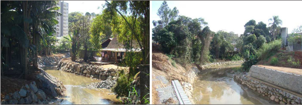
Figuras 10 e 11 - Obras de macrodrenagem no Ribeirão Fortaleza
